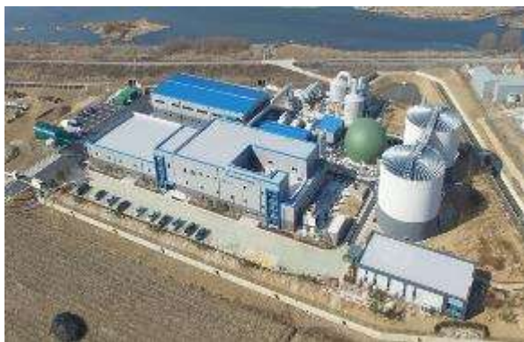
영천, 경상시 유기성폐기물 광역에너지화시설
