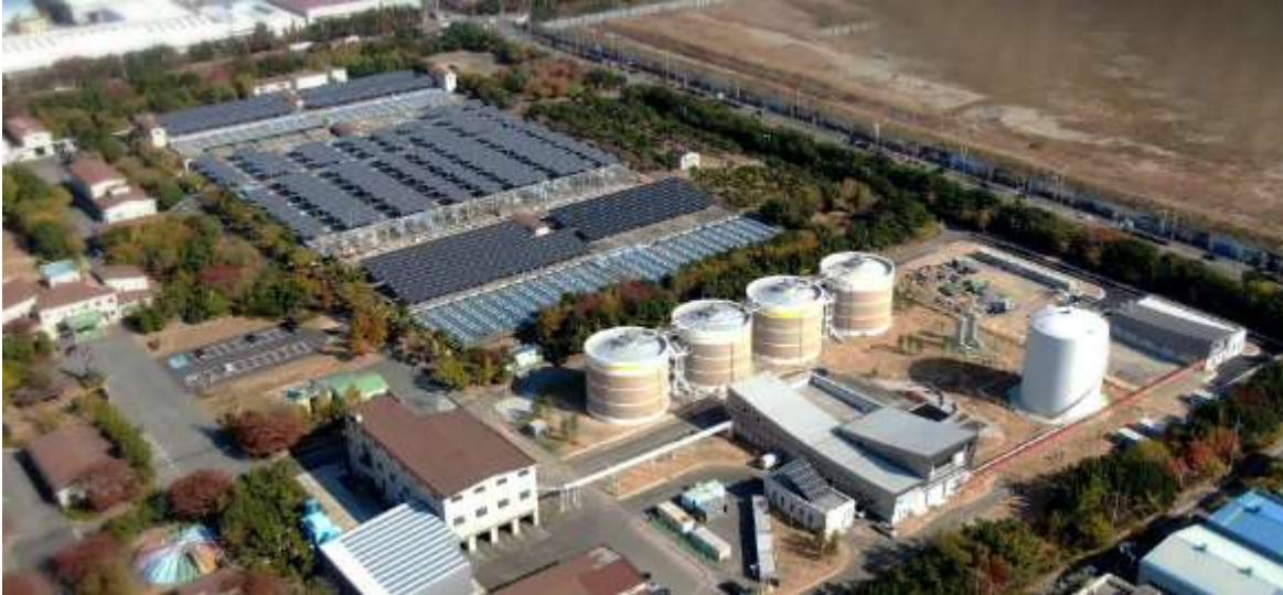
부산녹산하수처리장 소화조 설치사업 중 탈리여액 처리 설비(780m 3 /일)
