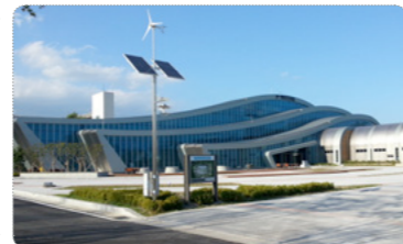
포항시 포항 하수 재이용시설
